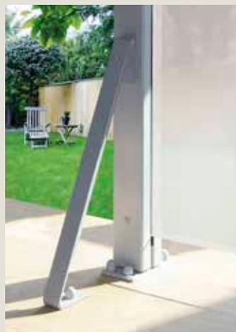
Beim Einsatz auf einem „wind- und sturmoffenen“ Gelände, zum Beispiel auf einer an ein freies Feld grenzenden Terrasse oder in Küstennähe, muss die SYSTEM Anlage zusätzlich zu der normalen Befestigung am Boden gesichert werden. Die Glaselemente halten dem Winddruck stand. Der Winddruck überträgt sich jedoch auf die Pfosten und die Bodenanker. Ab einer höheren Windstärke kann sich die Pfostenbasis verbiegen.
